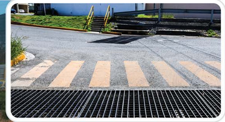
Pluvial Av. Conductores
