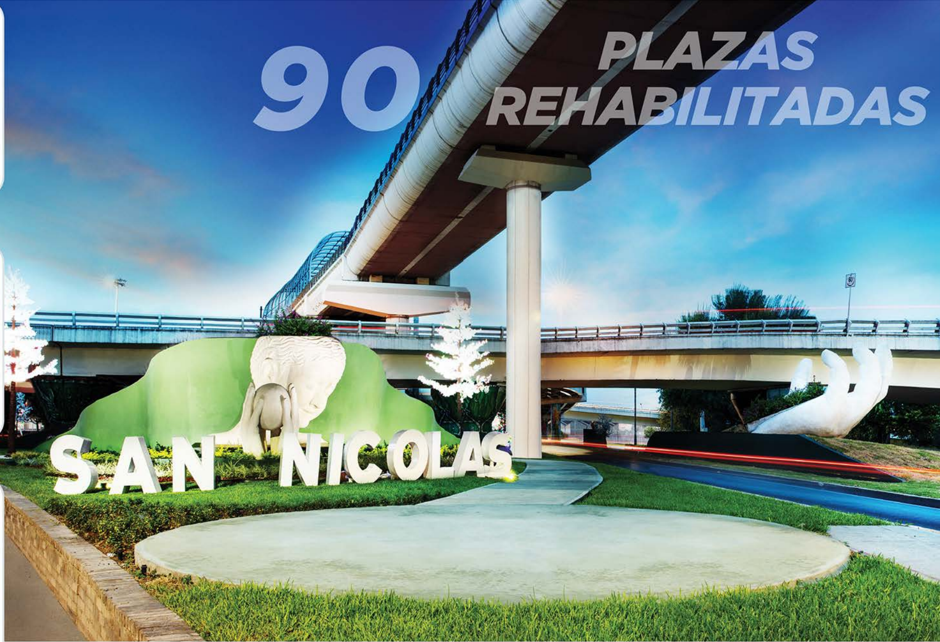
Rehabilitación de entrada a San Nicolás
